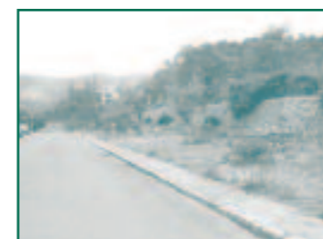
Carrer de les Filadores
