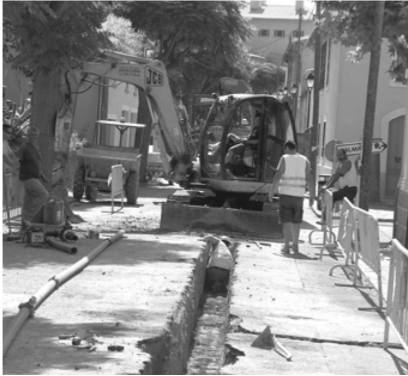
Treballs al carrer can arboç
