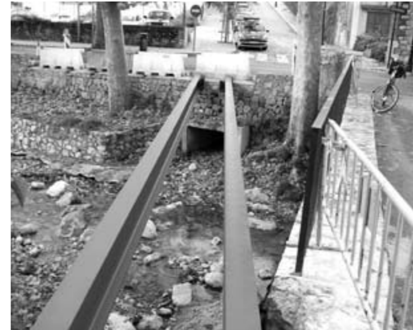
Les bigues mestres de la passarel·la del Pont de Fusta
